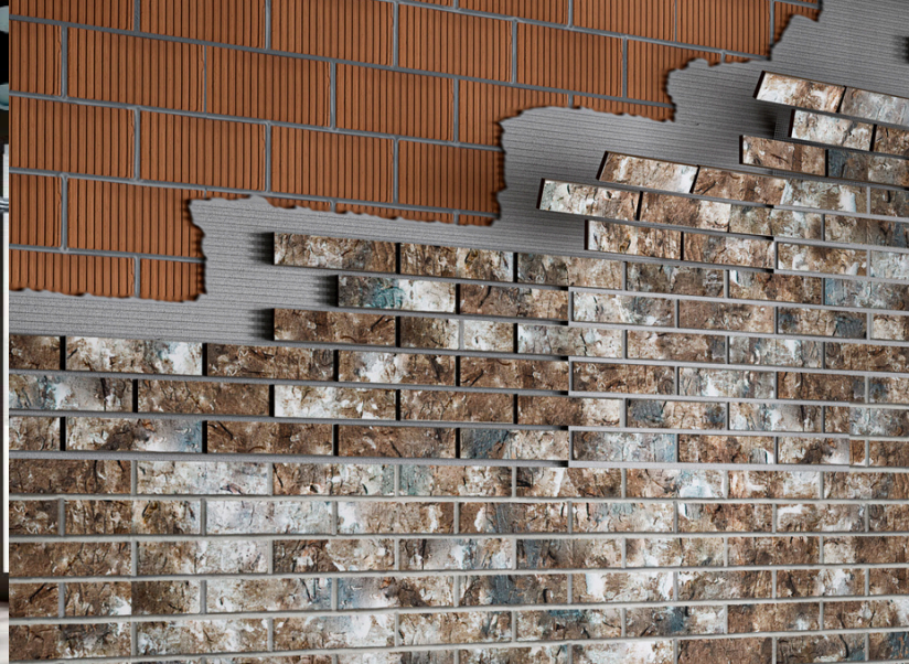
COLOCACION DE MALLA
